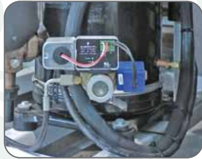
Control Electrónico Nivel Aceite: que monitorea, mantiene y protege el nivel apropiado de aceite en los compresores.
