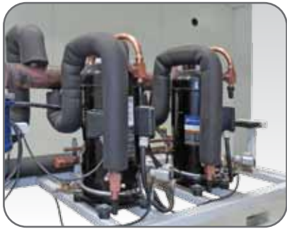
Compresor Scroll Digital y Estandar: Se caracterizan por su alta eficiencia, menor número de partes móviles y operan con bajos niveles de ruido y vibración. Contiene regulador electrónico de nivel de aceite, válvulas de servicio tipo Rotalock y resistencia.
