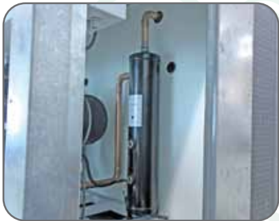
Separador de Aceite Centrifugo: Contiene dos mirillas proporciona una indicación visual del nivel aceite y una válvula Rotolock para el puerto de retorno de aceite.
