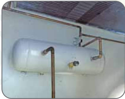
Recibidor Líquido: de acero, con válvula de seguridad y mirilla.
